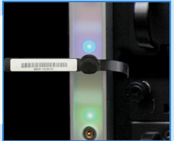
アセットマネジメントセンサー (AMS) AMTのID情報を読み取るセンサー 各U毎にカスタマイズ可能なRGBカラーLED
